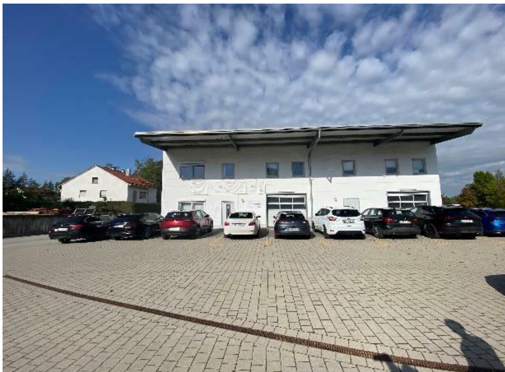
Verwaltungsgebäude mit Werkstatt
